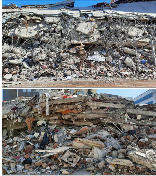
Şekil 2. Adıyaman kent merkezinde 6 Şubat depreminde yıkılan iki adet yapı [4].
